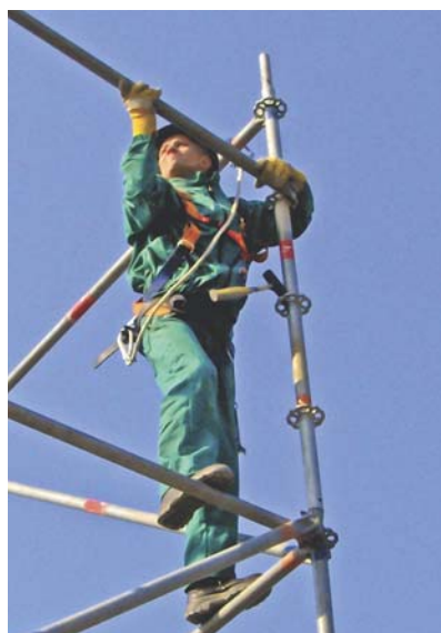
Fot. 1. Monter rusztowań.
