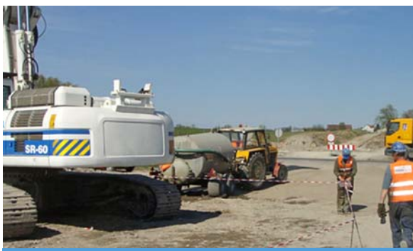
Fot. 8. Wydzielenie i oznakowanie strefy niebezpiecznej pracy maszyny.
