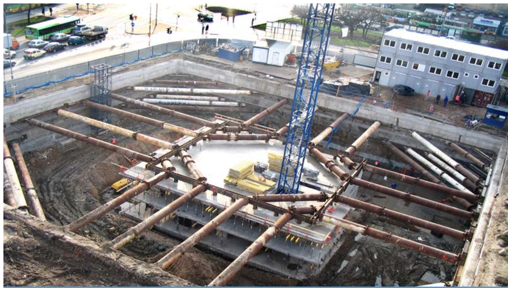
Fot. 27. Rozparcie ścian szczelinowych w narożniku wykopu w sąsiedztwie istniejącego budynku.
