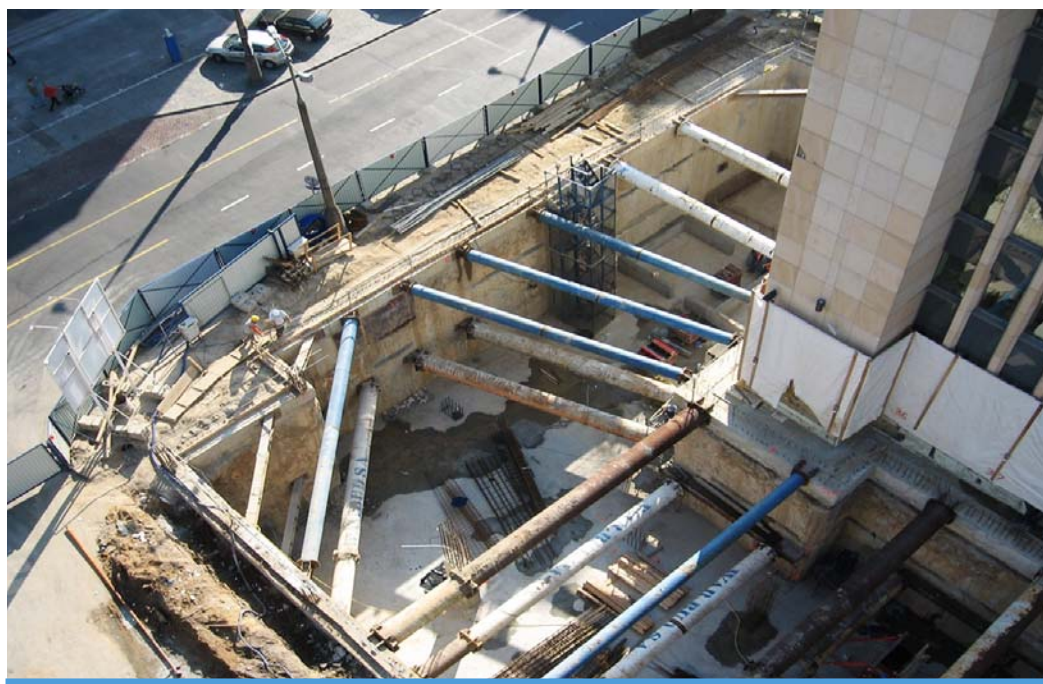
Fot. 26. Rozparcie ścian szczelinowych w narożniku wykopu w sąsiedztwie istniejącego budynku.
