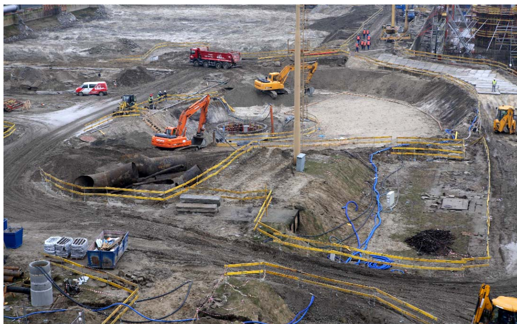
Fot. 2. Plac budowy oczyszczalni ścieków „Czajka” w Warszawie. Roboty budowlane, w tym ziemne, prowadzone były na placu budowy o powierzchni 50 ha.
