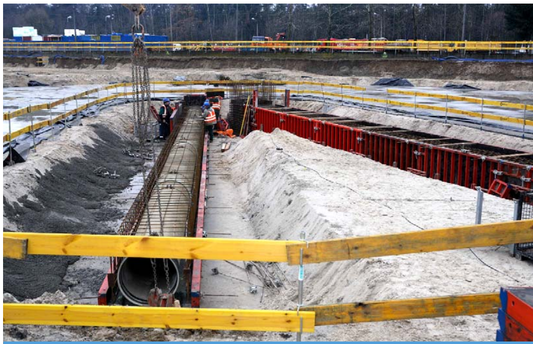
Fot. 10. Wykop o głębokości do 1,25 m.
