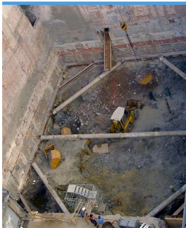
Fot. 24 i 25. Przykłady wykopów zabezpieczonych przy pomocy palisady z kolumn jet-grouting.
