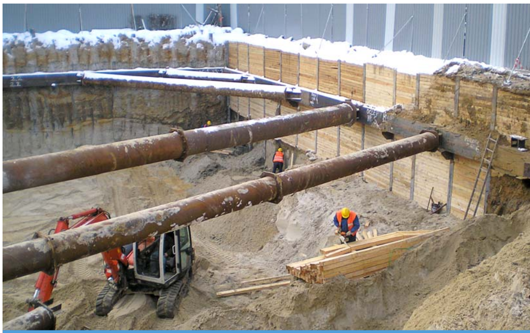
Fot. 20. Zabezpieczenie wykopu wykonane ścianką berlińską. Zastosowano kształtowniki stalowe oraz dodatkowo rozparto rurami stalowymi wspartymi na oczepach.
