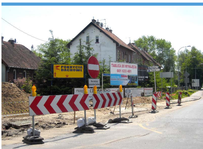
Fot. 32. Zabezpieczenie robót ziemnych prowadzonych w bezpośrednim sąsiedztwie jezdni. Umieszczono znaki drogowe, taśmę ostrzegawczą w barwie czarno-żółtej oraz ostrzegawczą sygnalizację świetlną.
