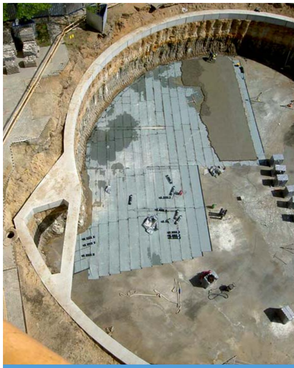
Fot. 22. Zdjęcie przedstawia palisadę z kolumn DSM usztywnioną ocepem żelbetowym.
