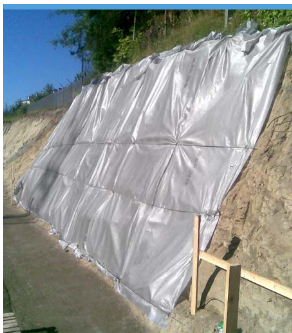
Fot. 12. Powierzchniowe zabezpieczenie skarpy geowłókniną z systemem pionowych/poziomych prętów zbrojeniowych przymocowanych do skarpy za pomocą szpilek.
