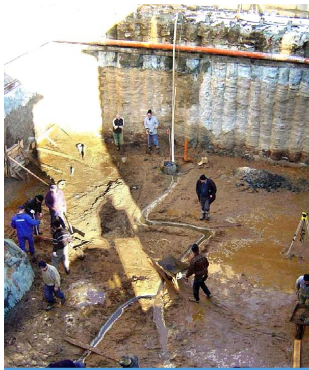
Fot. 24 i 25. Przykłady wykopów zabezpieczonych przy pomocy palisady z kolumn jet-grouting.
