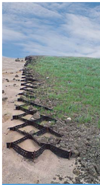
Fot. 18. Elementy systemu geokrat gotowe do zasypania kruszywem.
