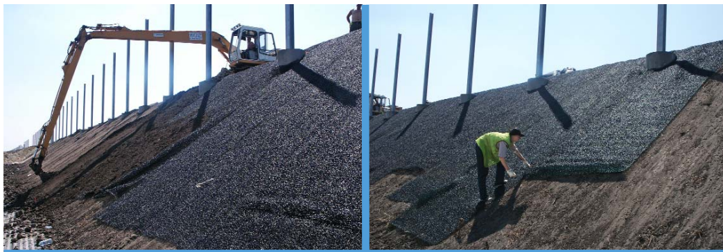
Fot. 13 i 14. Wyprofilowana skarpa zabezpieczona geotekstyliami.
