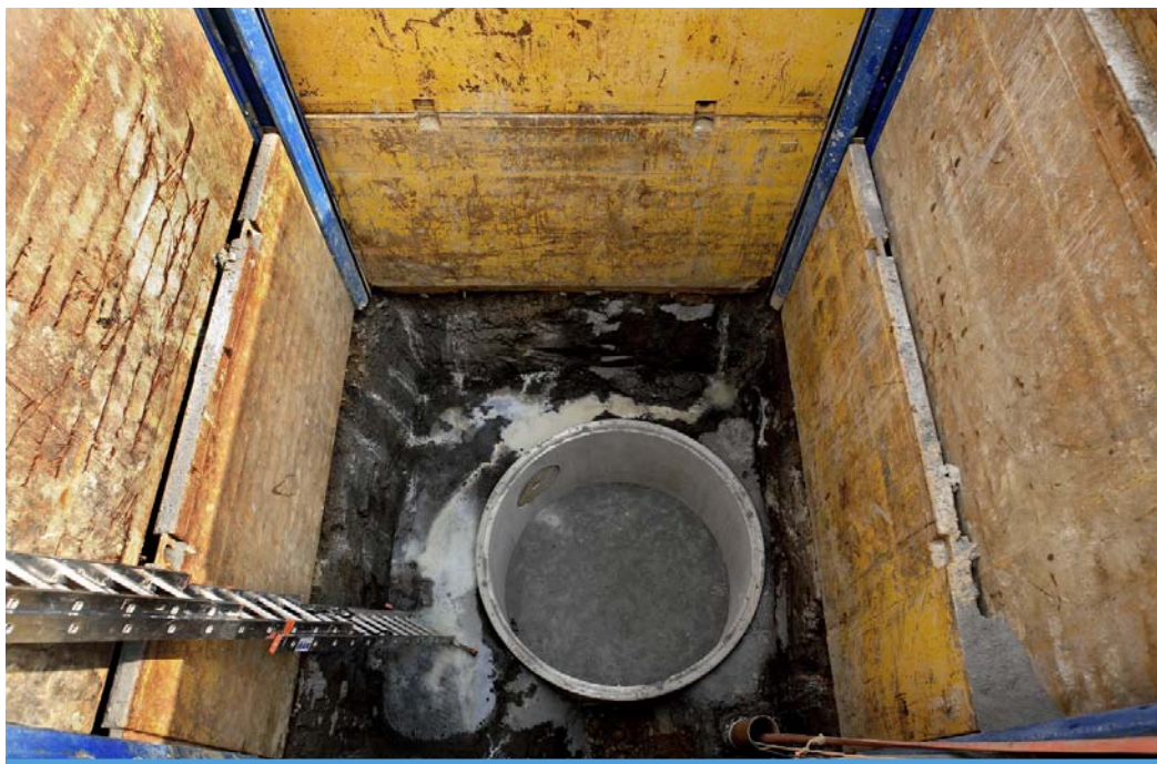
Fot. 29. Zabezpieczenie wykopu poprzez zastosowanie systemowego rozwiązania, na które składają się panele i belki.
