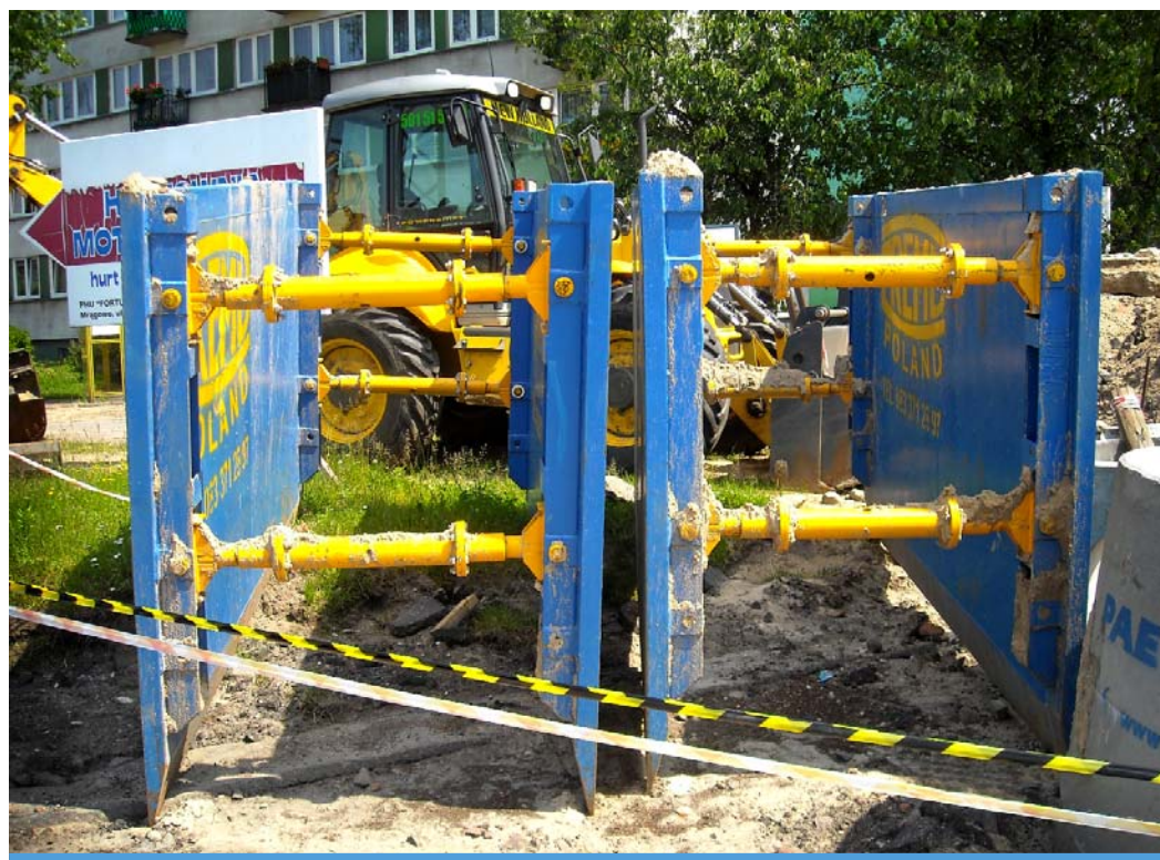
Fot. 30. Elementy systemowe przygotowane do montażu w wykopie.
