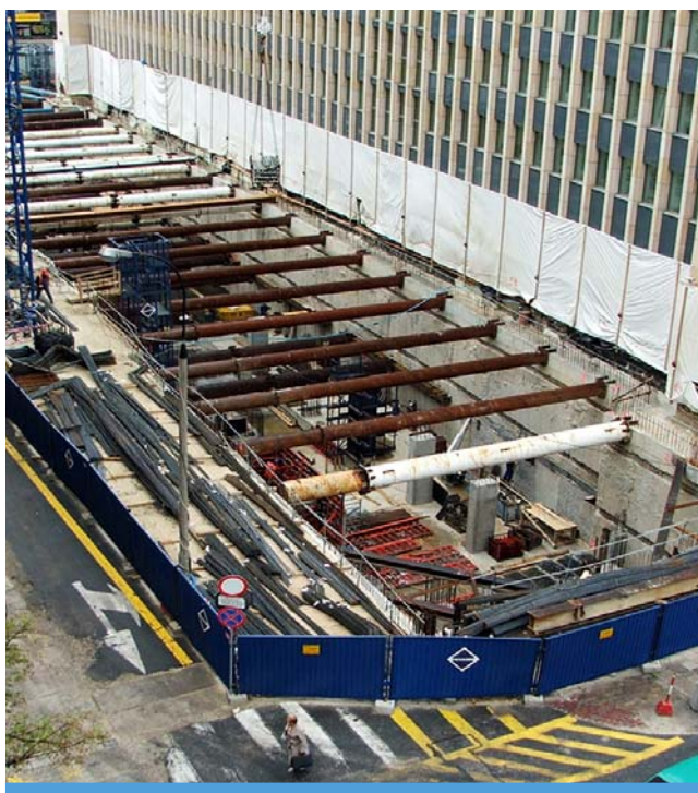
Fot. 28. Zabezpieczenia głębszych wykopów.
