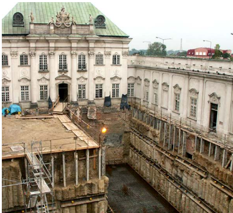
Fot. 22. Zdjęcie przedstawia palisadę z kolumn DSM usztywnioną ocepem żelbetowym.
