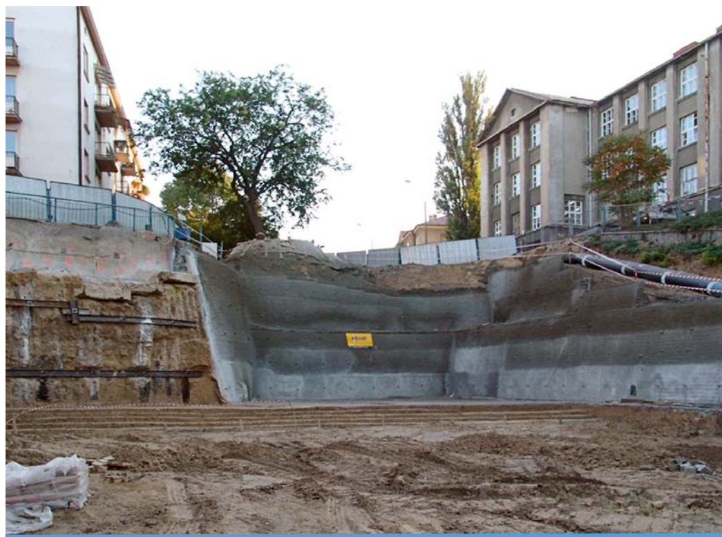
Fot.1. Roboty ziemne prowadzone w ścisłej zabudowie miejskiej. Przygotowanie robót w takim terenie wymaga szczególnej analizy dokumentacji archiwalnej oraz monitoringu oddziaływania robót na stan przyległych do placu budowy obiektów.
