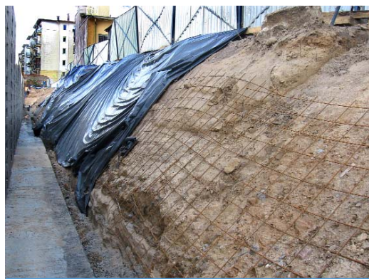
Fot. 16. Etapy wykonania zabezpieczenia skarpy poprzez ułożenie zbrojenia i w następnej kolejności mieszanki betonowej.
